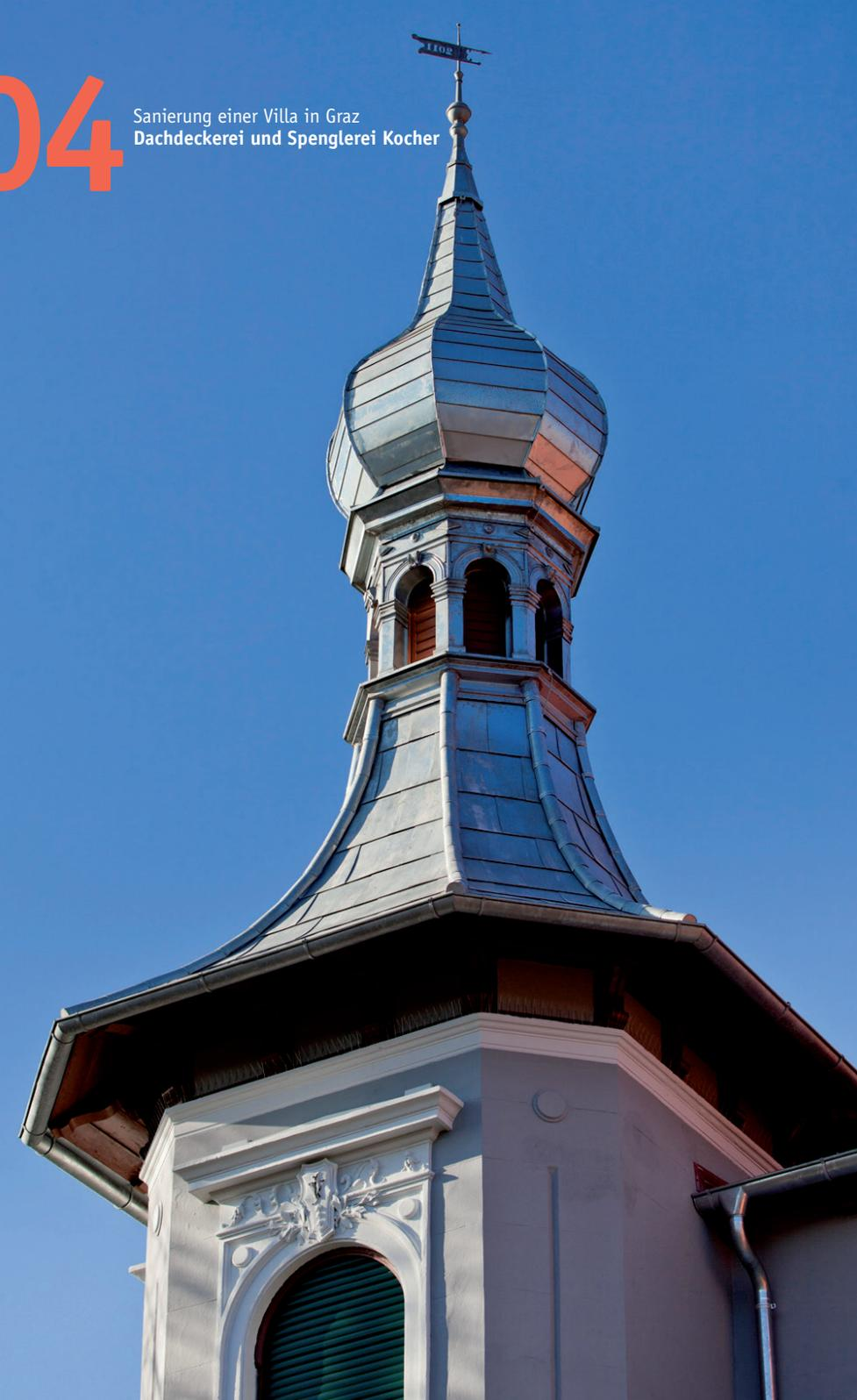
**R**estauriert und erhalten werden konnten vier Metall-Firstspitzen bei der Ziegeldachfläche, die aus der Erbauerzeit des Gebäudes stammen. Diese Firstspitzen wurden nach dem Restaurieren farblich an die legierten Zinkbleche angepasst.
